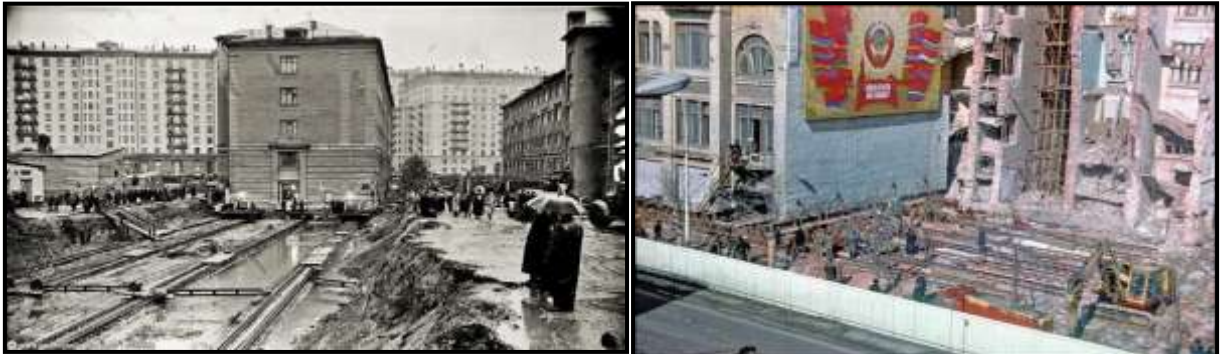
Рис. 1 Перемещение многоквартирных домов
