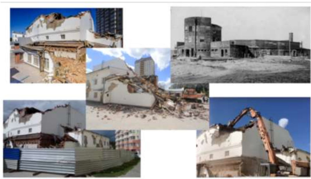
Рис. 4. Здание кинотеатра «Металлист» г. Новосибирск
